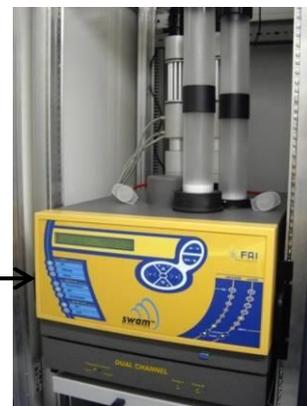
Figure 2 : baie de mesure contenant les analyseurs
